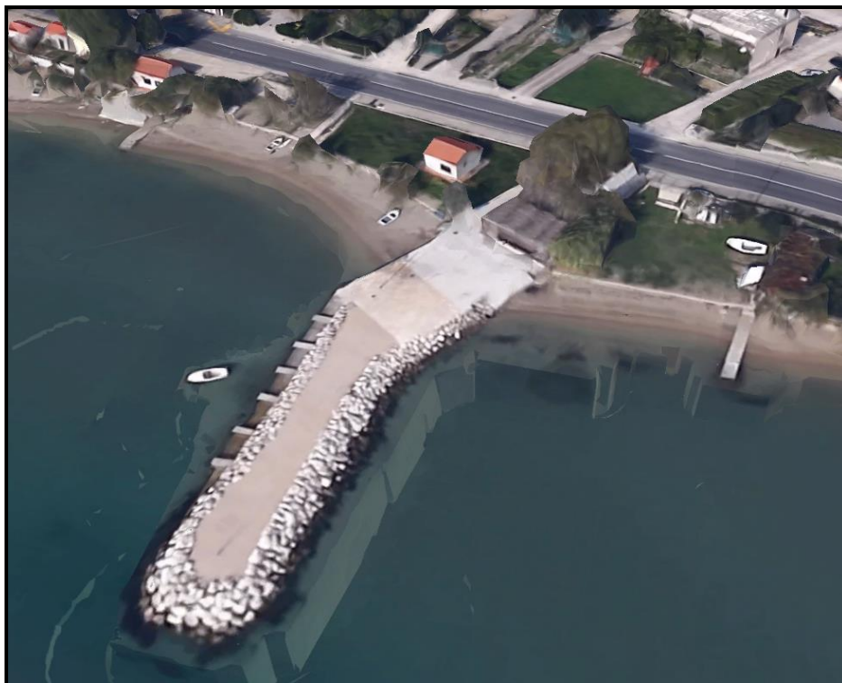
Slika 2.1-1. Crpna stanica Rogač i plažno pero u koje je položen postojeći incidentni preljev (pogled iz zraka)
